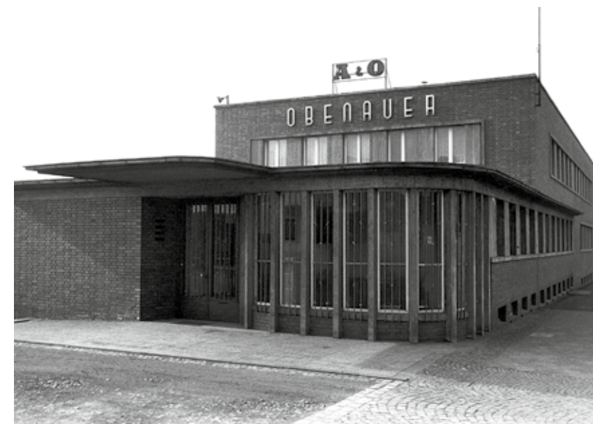
Gebäude Obenauer aus den 60ern
